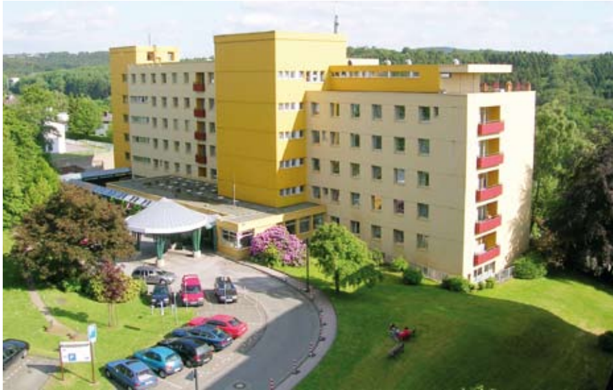
Über 40 Jahre mit der Kinder- und Jugendmedizin in Lüdenscheid untrennbar verbunden: das Klinikgebäude an der Hohfuhrstraße, das mittlerweile abgerissen wurde.
