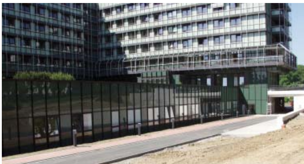
Im rechten Bereich des Anbaus Nord ist die neue Zentrale Aufnahmestation untergebracht.
