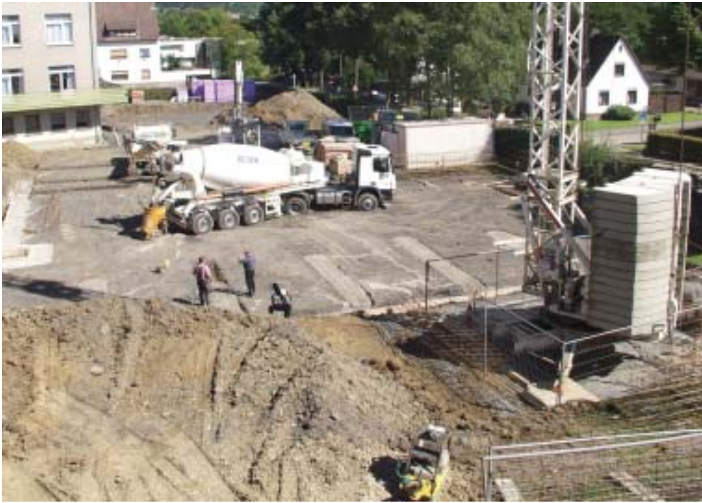
Auf dem Gelände des Marienhospitals haben die Arbeiten zum Neubau des Seniorenzentrums begonnen. Die ehemaligen Grünflächen zur Lindenstraße hin sind mittlerweile zur Großbaustelle geworden.
